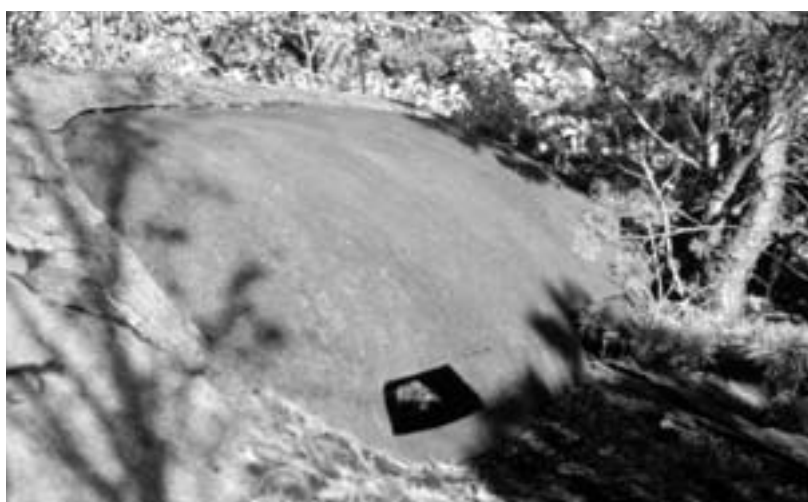
Panserkuppelen over stasjonen, med sikteåpning.
